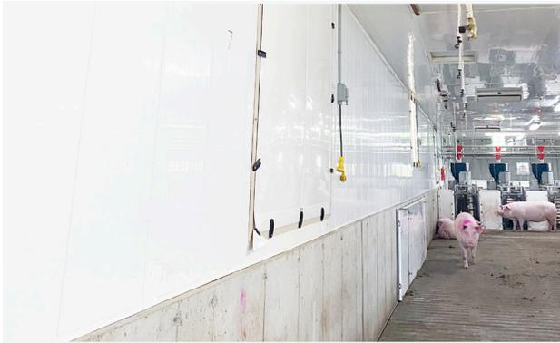
Utilisez légers et non poreux Trusscore Wall&CeilingBoard pour tous les murs et les plafonds porteurs. Ils sont faciles à nettoyer et ils peuvent supporter des lavages sous pression répétés et résister aux gaz agressifs présents dans l'air.
